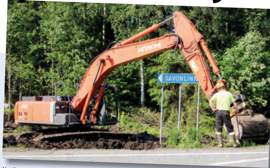
Huollettu kone ei hidasta työn tekoa merkitsemättömien kaapelikourujen tapaan. Seppo Saarelaisen kone Puhoksella etsimässä tien ali porattuja kouruja.
