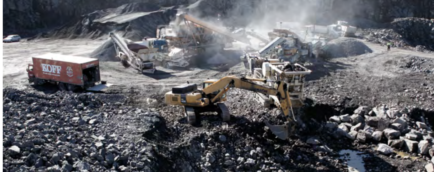
Perusmaan Routakallion työmaalla Seinäjoella syntyy laatumurskettä.
