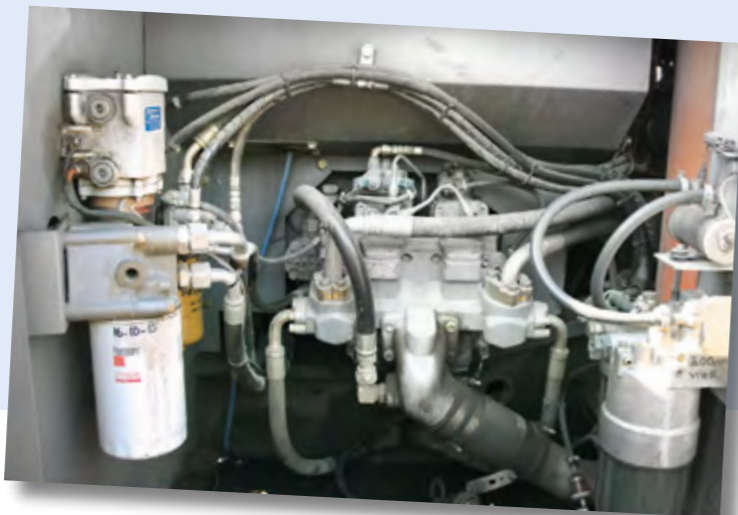
Palotarkastuksessa yhtenä kohteena on hydrauliliikkipumpun letkut ja johtimet.
