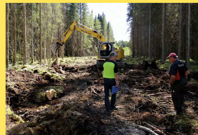
Riskolan metsäautotien kaivutyömaalla hankkeen puuhamiehet, Ukkonen & Heikkinen, asiasta lisää lehdessämme sivulla 30
