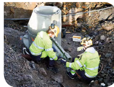
EAT:n suorittaja Eero Hänninen opastaa työsuojelijaa Toni Saaria miten on meneteltävä, kun kaivonrenkaaseen porataan halkaisijaltaan 225 mm reikä.
