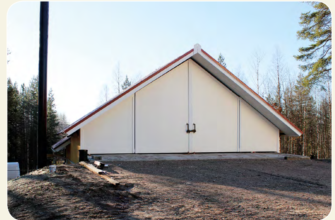
Hakelämpölaitos maastoutuu hyvin maisemaan. Koulut sijaitsevat yleensä kylän parhaalla paikalla eli mäellä, jota voidaan hyödyntää sijoittamalla laitos rinteeseen osittain maan alle. Pariin tasaisella olevaan laitokseen on jouduttu rakentamaan rintuus hakkeen ajoa varten.
