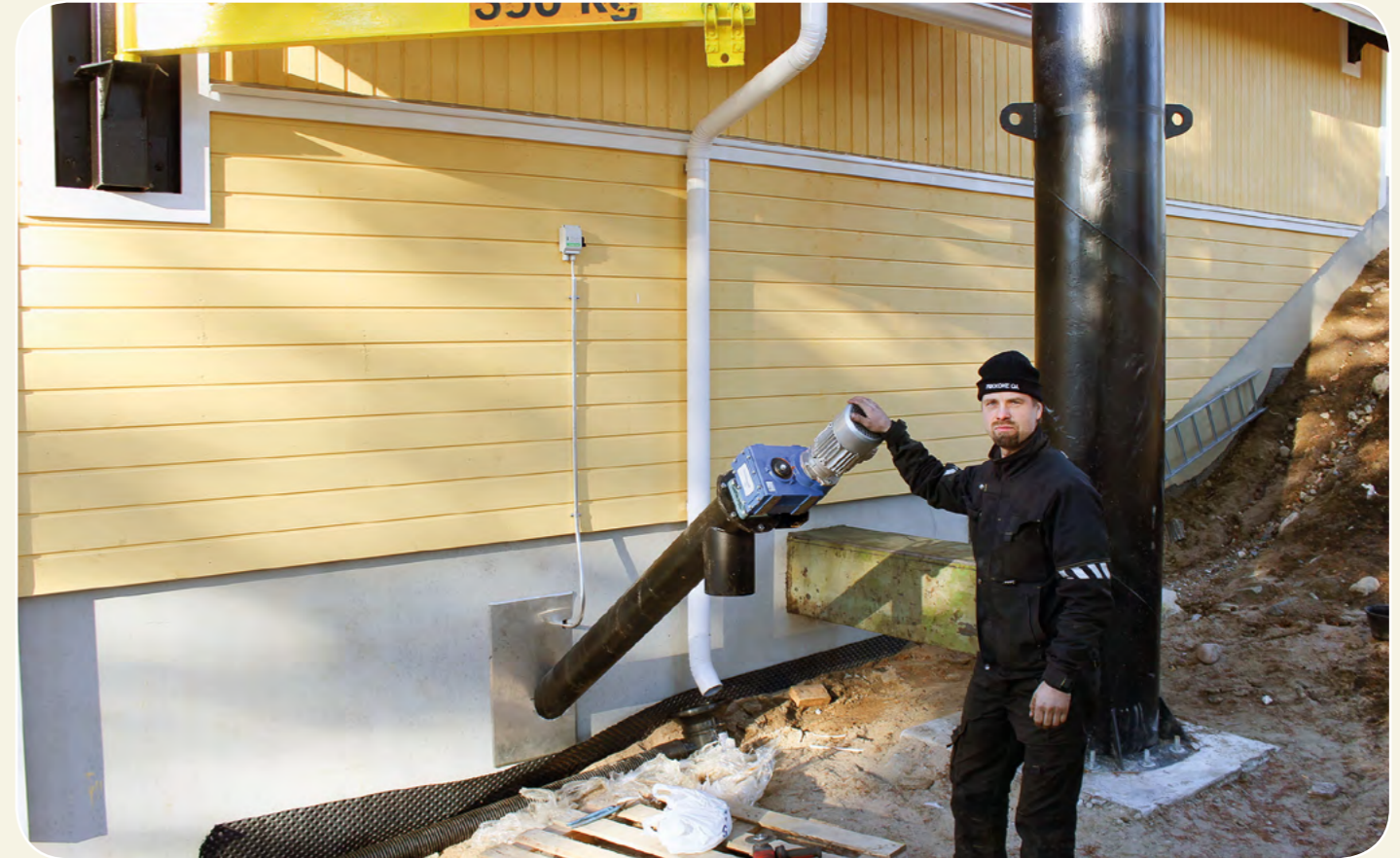
Hakelämpölaitoksen kattilan tuhkia varten on rakennettu siirtoputki ja tuhkasäkki voidaan siirtää nosturilla suoraan autoon. Mikko Sirviö sanoo suunnittelussa pyrityn mahdollisimman toimiviin ja helpokäyttöisiin ratkaisuihin.
