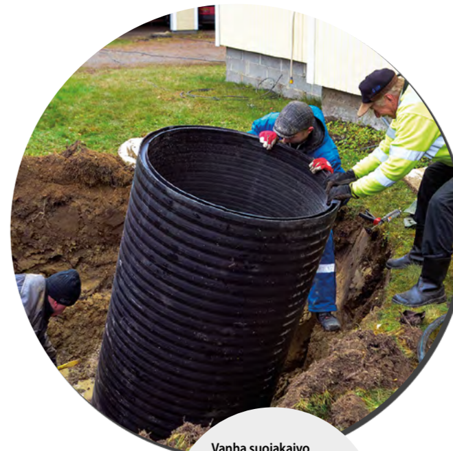
Vanha suojavaivo korvataan helposti työstettävällä rumpuputkella. Kuvassa Ristiinan Porakaivon miehet Sami Juopperi (vasemmalla) ja Taneli Purhonen. Risto Soikkeli auttaa oikealla.
