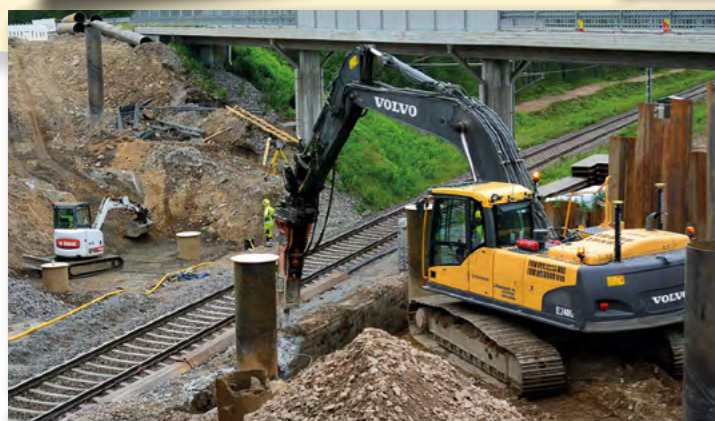
Samaan aikaan kun vanhaa silta-arkkua hakataan rikki, Seinäjoen kiintorakenne Oy tekee toisella puolella rautatietä putkipaalutetun perustuksen pohjaa.
