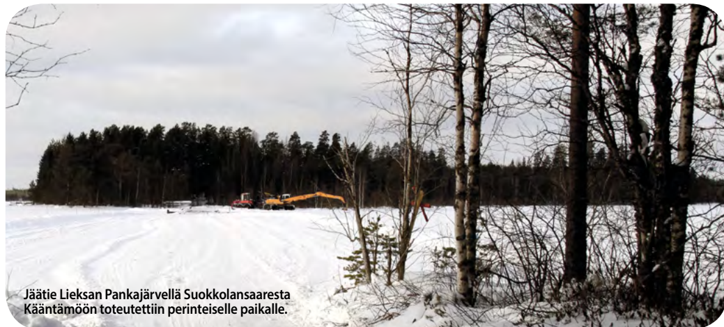
Pohjaan jäädytetty jäätie kantaa täyteen kuormatun puutavarayhdistelmän, myös yhdeksänkuisella on puuta käyty hakemassa. Kuva Risto Puumalainen.
