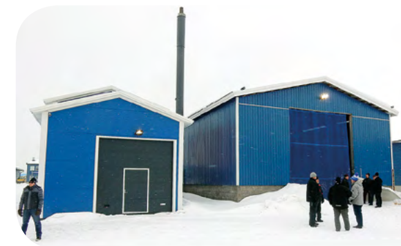
Kittilän lentoaseman (Finavia) alueen lämpölaitos on 700 kW:n kotimaisen hake-energian laitos. Omistaja on Kittilän Aluelämpö Oy.
