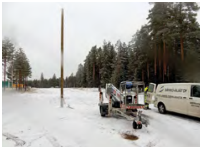
Sähkö-Äijät Oy:n asentajat asensivat valaistusta 15.11.2017. Sähkökaapelit on aurattu maahan.
