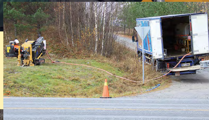
Vettä kuluu suuntaporauksessa paljon, joten säiliöt kulkevat mukana kuorma-autossa.
