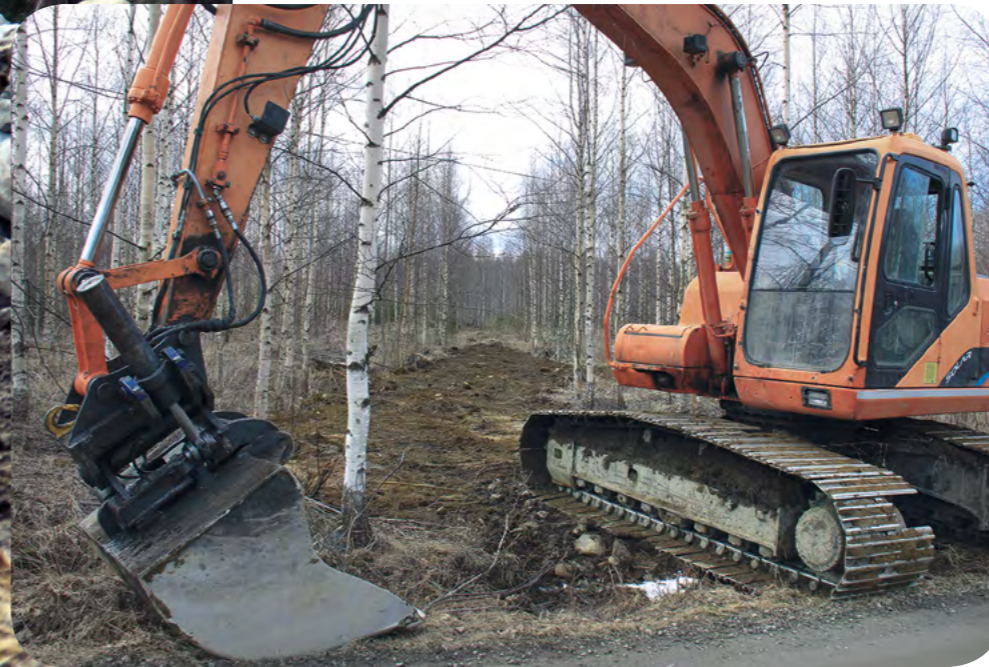
Koivikkosavottaa on tehty kolmisen viikkoa. Osa kiviaineksesta on siirretty rammeroituna odottamaan seuraavaa siirtoa, osa upotettu metsänpohjaan.
