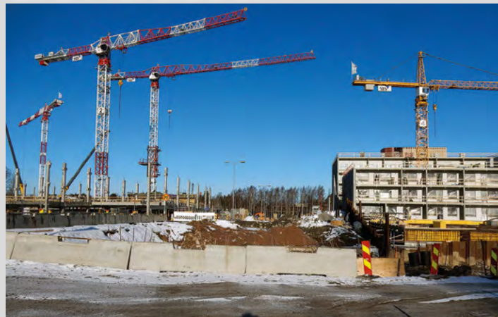
Niittykunnan huoltotunnelin päälle ja viereen tulee asuinkerrostaloja.
