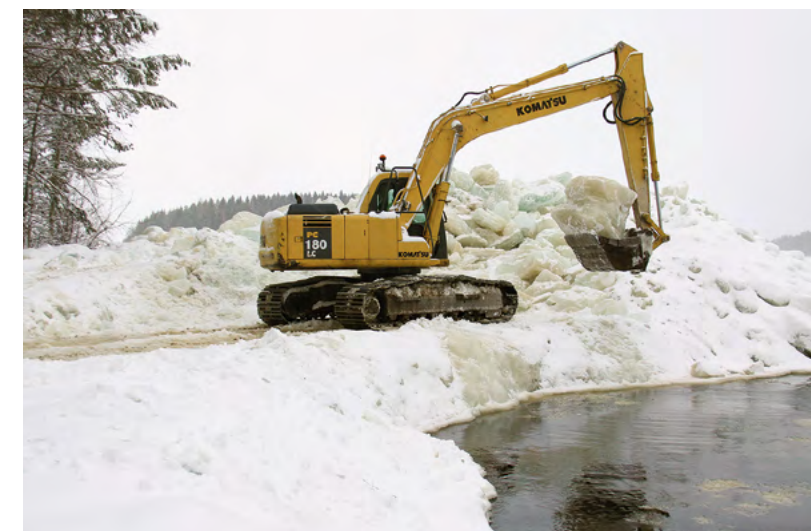
Jäälohkareiden nostaminen vedestä on oma taitolajinsa. Tässä homma on jo tehty, pahimmillaan allas on täynnä hädintuskin kauhaan mahtuvia lohkareita.
