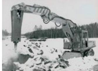
Suomalaista konevalmistuksen historiaa – Ukko-Mestari 1680 M varustettuna ensimmäisellä Roxon-hydrauliivasaralla. Kaivukoneita ei enää maassamme valmisteta, mutta Roxonista kehittyi menestystarina nimeltään Rammer!
