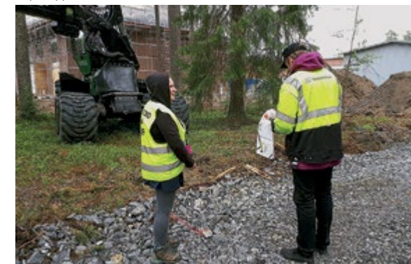
Gradia Jämsän uuden kone- ja huoltohallin rakennustyömaa on muuttanut maisemaa näyttelyn ydinalueella.
