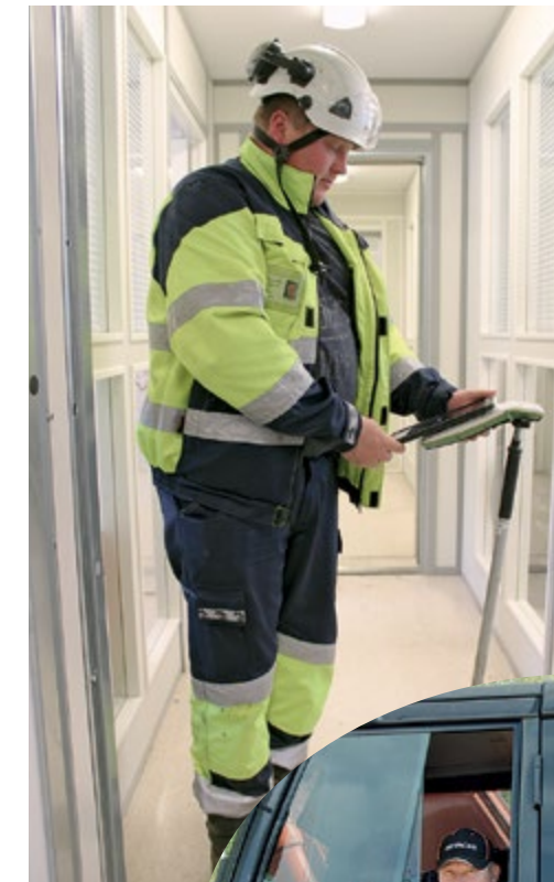
Ab Tallqvist Infra Oy:n työmaapäällikkö Jari Kinnunen esittelee "mittakeppiä", jolla työmaan korot tarkistetaan ennen mallinpäivittämistä.
