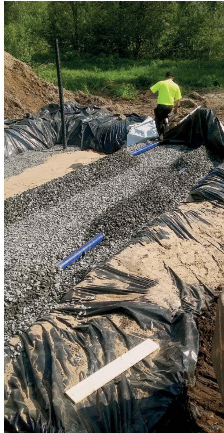
Maasuodattimen rakentaminen käynnissä. Kuva Juha Koivisto.
