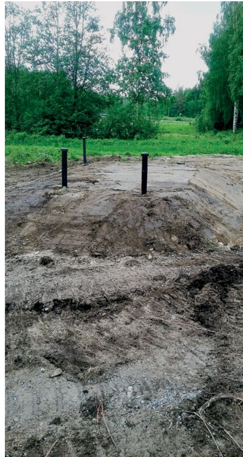
Valmis maasuodatin. Kuva Juha Koivisto.
