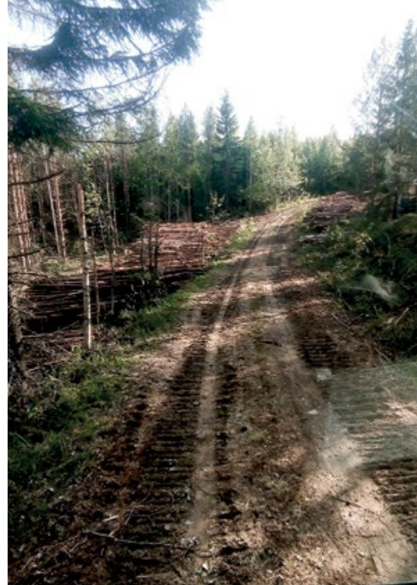
Hyvin tehty metsäautotie: leveä tie, puskat ja oksat karsittu pois.
