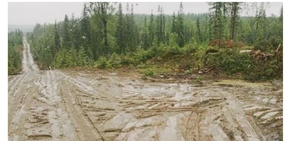
Uusi metsäautotie kestää kuivalla kelillä ajamista, mutta sateella olosuhde voi muuttua säiliöautolle vaikeaksi.
