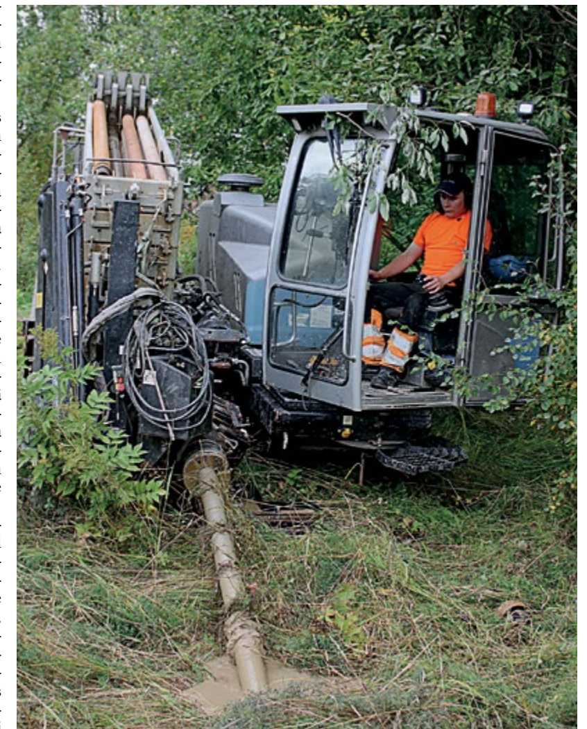
Marko Kärnä suuntaporaakaksoistankokoneella rautatien alitusta sähkökaapelille lislamessa.
