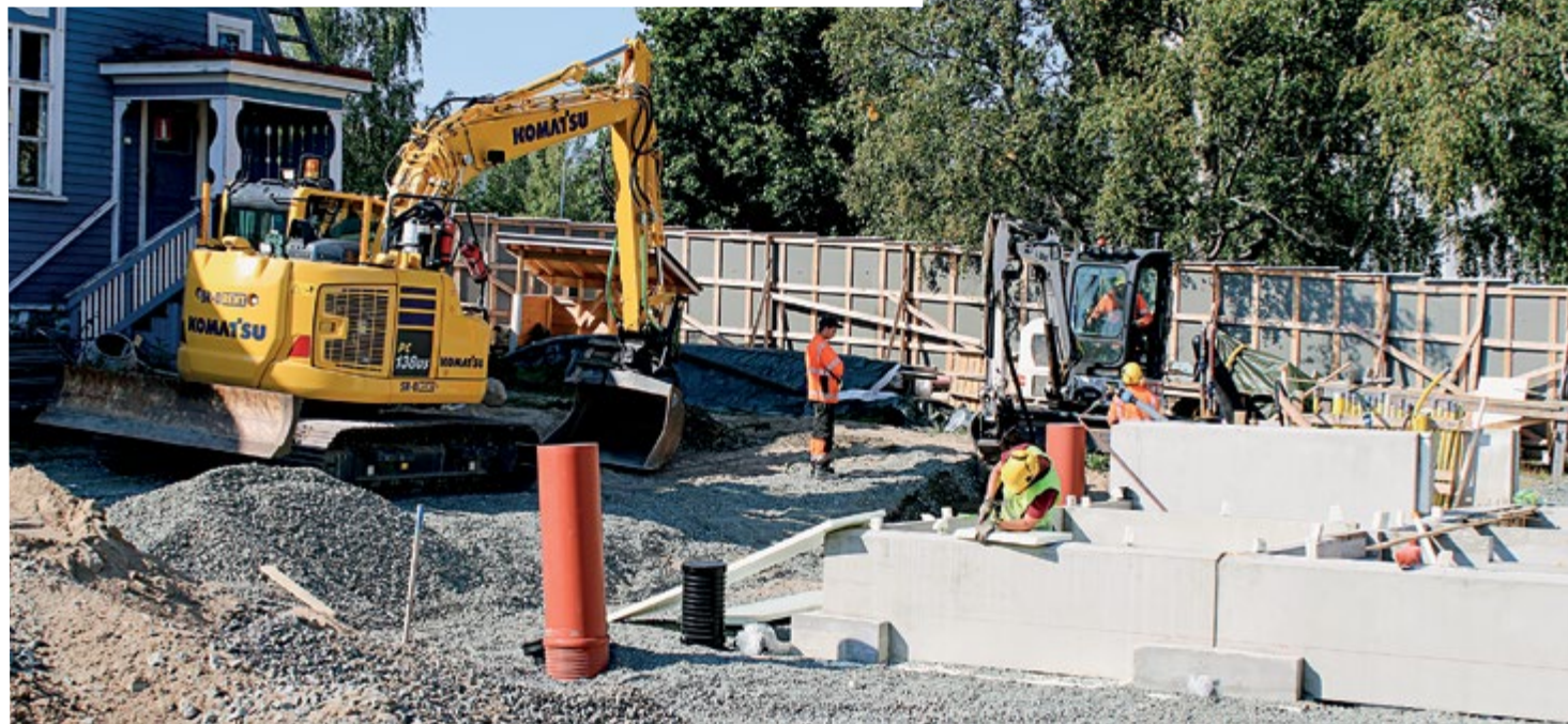
YSAO:n rakennusalan perustutkintoa opiskelevat rakentavat oppilastyönä kaksi rivitaloa melkein lisälmen keskusta, sekä peruskorjaavat kuvassa olevan sinisen talon asunnoiksi.
