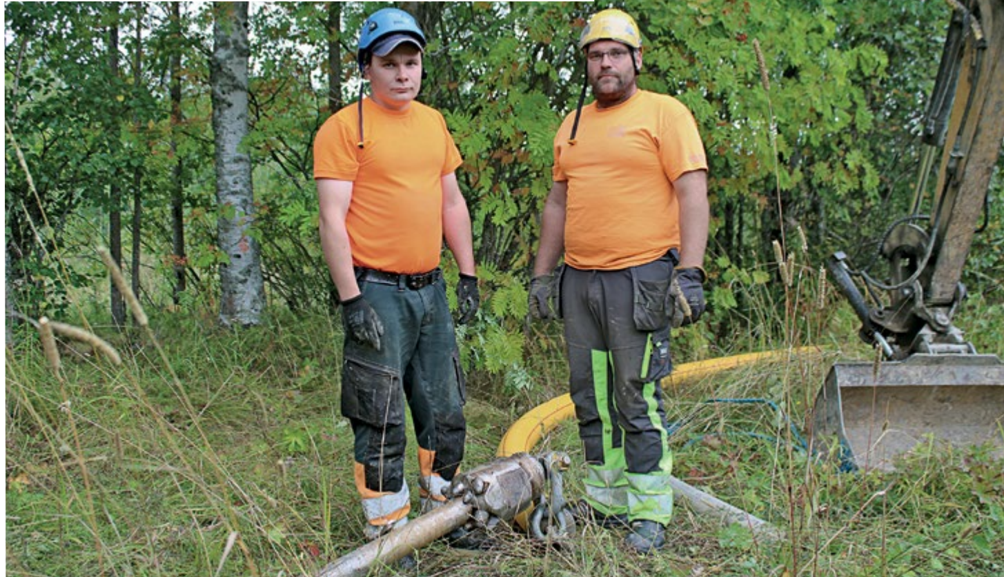
Suuntaporaajat Marko Kärnä ja Heikki Huttunen ovat asentaneet avartimen ja aloittavat pian kaapelinsuojaputken vetämisen pilottireikään.
