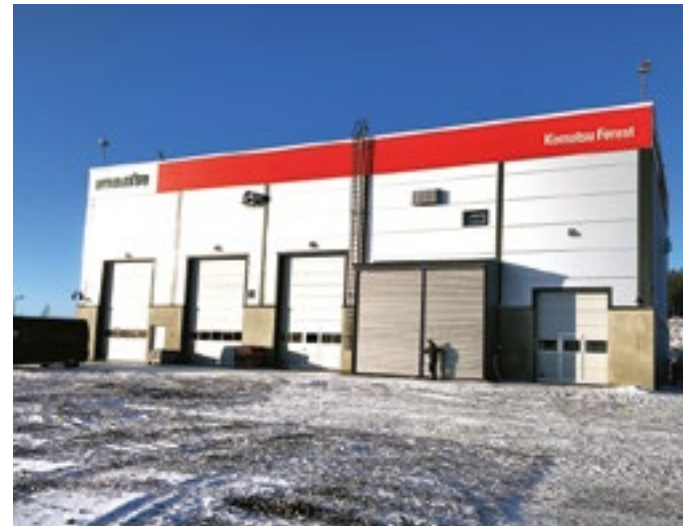
Komatsu Forest Oy muutti tammikuun lopussa uusiin toimitiloihin Jyväskylässä. Kuvanottohetkellä muutto oli käynnissä.
