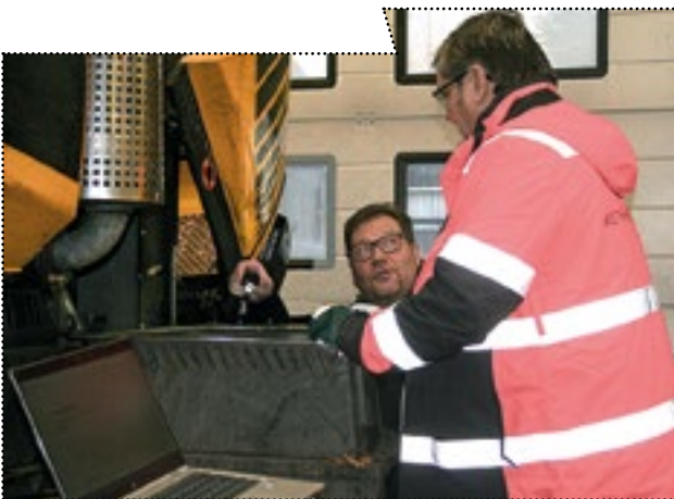
Jarmo Neuvonen (vasemmalla) tarkistaa Metsä-Weljet Oy:n metsätraktorin akkujen päävirtakaapeleita, releitä ja sulakkeita. Antti Ihalainen yrityksestä seuraa. Kuvassa myös tietokone, jonka avulla käytettiin IF:n kehittämää paloturvallisuustyökalua.
