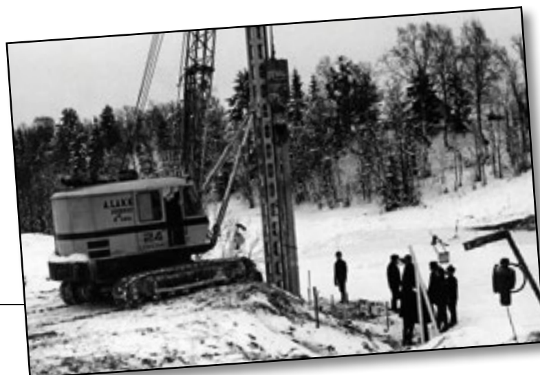
Kuosmasen sillan paalutusta Teräsmies-koneella Värtsilässä vuonna 1968. Koneen omistaja Ahti Lakka (myöhemmin Lakan Betoni Oy). Kuva: Infra ry/eMobilia
