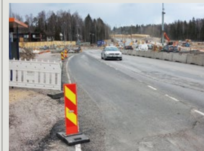
Raide-Jokerin 25 km mittainen suurtyömaa on täydessä käynnissä kehä I:sen rinnalla Laajalahdessa Espoossa.
