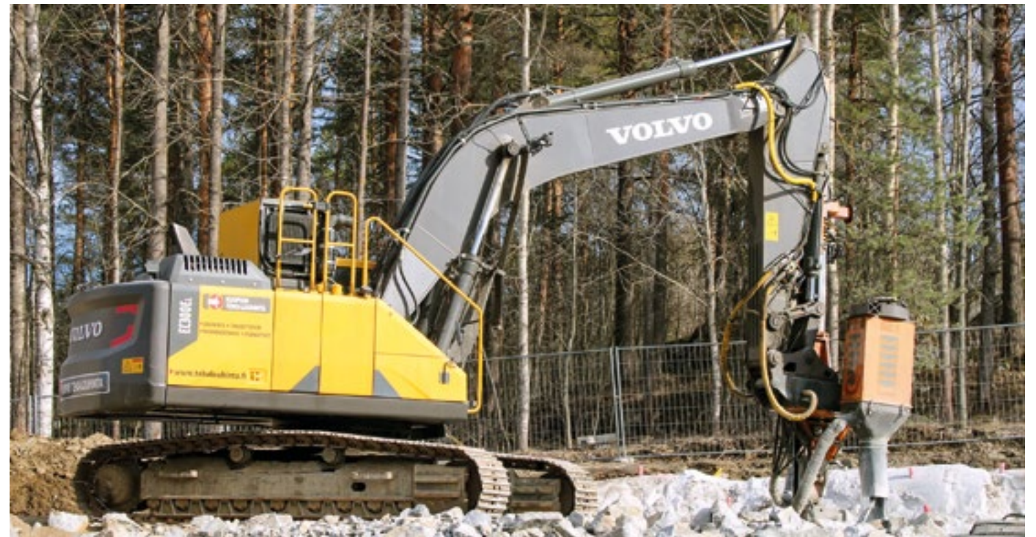
Kuopion Teholouhinta Oy:n kaivukoneeseen liitetty ExcaDrill kallionporauslaite on näyte paikallisesta koneenrakennustaidosta.
