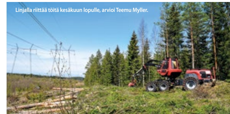
Johtoalue koostuu johtoaukeasta ja sen molemmin puolin olevasta reunavyöhykkeestä. Reunavyöhyke on yleensä 10 metriä leveä. Puiden kasvukorkeus on rajoitettu, jotta puu ei mahdollisesti kaatuessaan ulotu johtoon.
