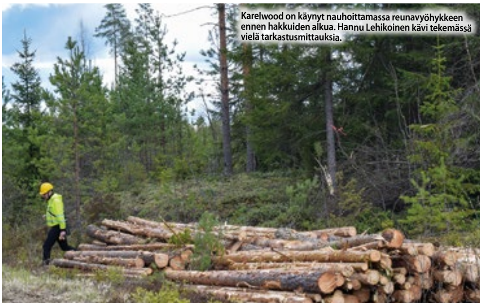
Johtoalue koostuu johtoaukeasta ja sen molemmin puolin olevasta reunavyöhykkeestä. Reunavyöhyke on yleensä 10 metriä leveä. Puiden kasvukorkeus on rajoitettu, jotta puu ei mahdollisesti kaatuessaan ulotu johtoon.
