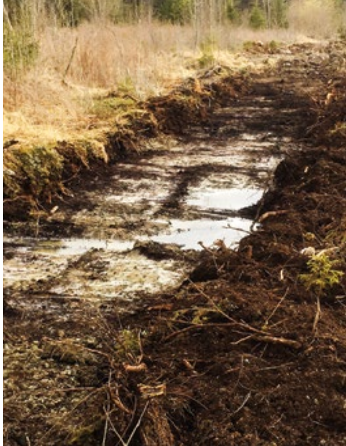
Kaivinkoneella tehty palokäytävä.
