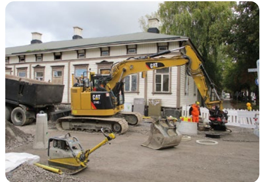
Päästöttömissä työmaissa pitää ratkaista muun muassa sähköistys ja mahdollinen lämmitys. Kaupunkiolosuhteissa kaikenkokoisten, tärjävyyttä kaivukoneisiin, olevien työkalu- ja lausaus voidaan järjestää helpommin kuin vaikkapa haja-asutusalueilla tai tietyömailla. (Kuva: Juho Halminen / FCG Suunnittelu ja tekniikka Oy)
