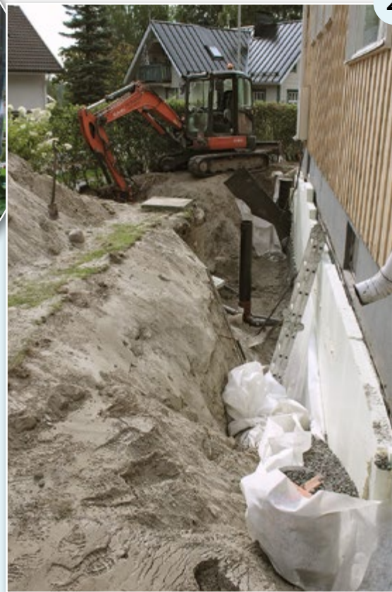
Kuva 1. Ari Kupiainen, tällä kertaa kaivukoneen puikoissa. Tämän vuoden toinen perustuksen kuivatustyömaa on jo loppusuoralla.
