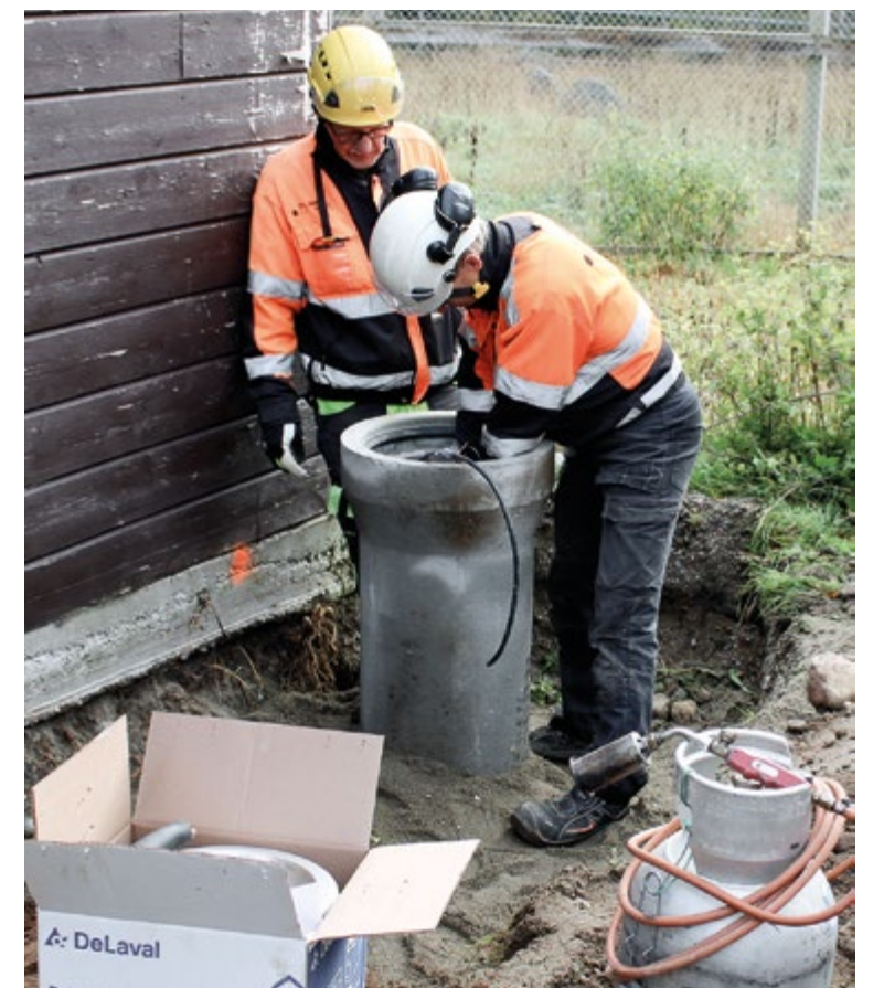
Hirvieläinten juoma-automaatin muoviputken sähkömuhvin hitsaamisen valmistelua. Etualalla pahvilaatikossa "malja" joka lopulta valetaan kiinni betoniputken päähän.
