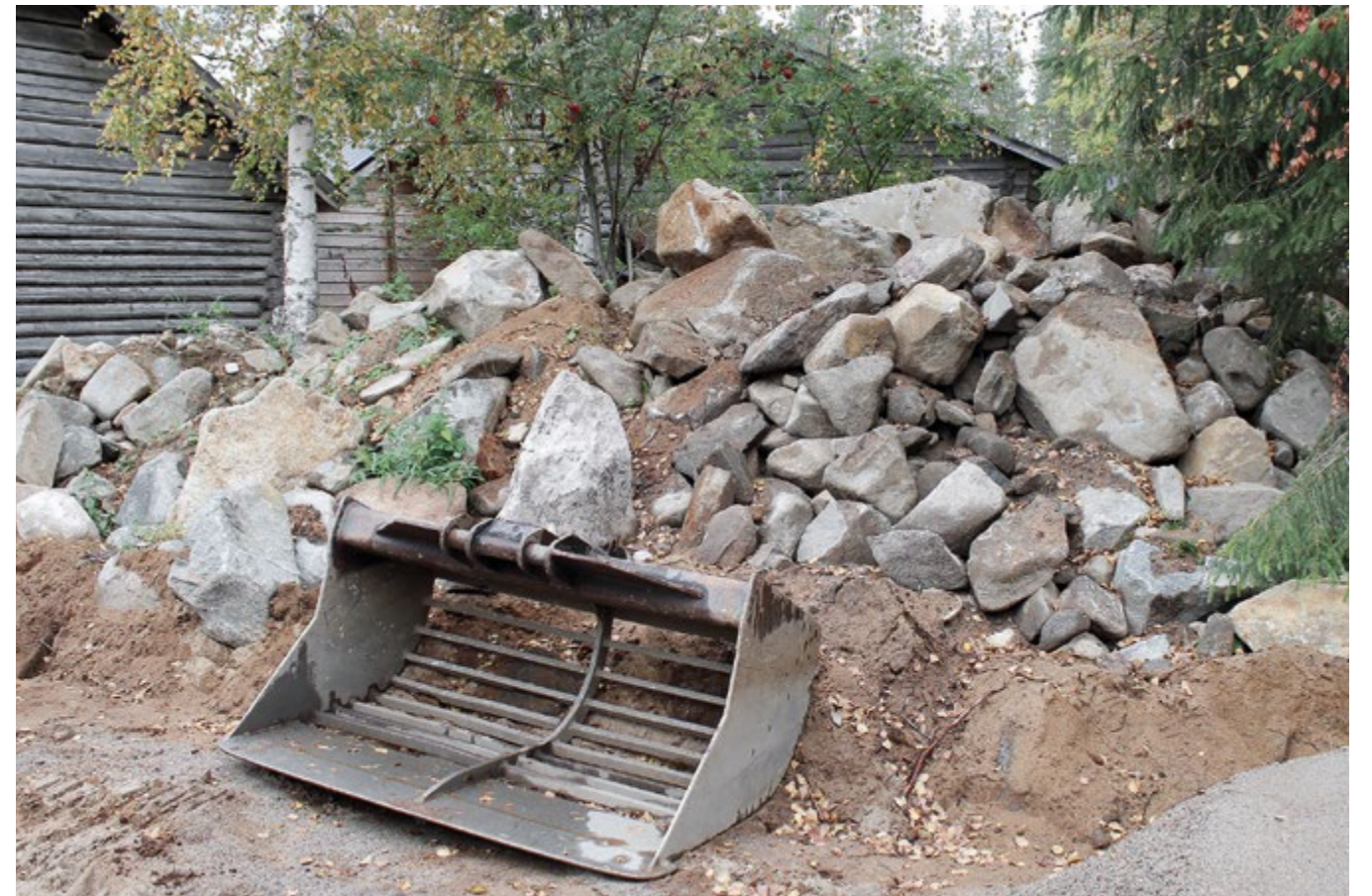
Kesän aikana putkikaivannosta nousseita kiviä.
