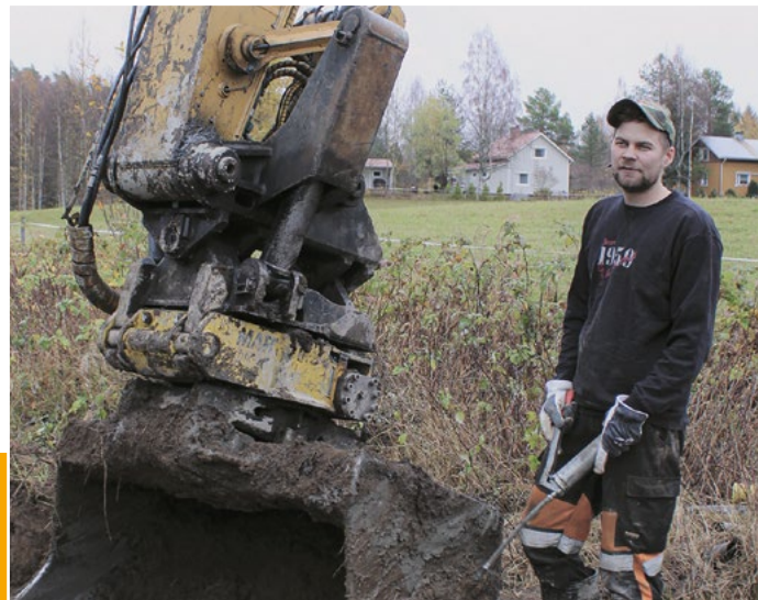
Kaivannon täytössä sopivan välin tullessa, vastuuntuntoisena kuljettajana Taneli Mykkänen rasvaa kauhauksella.
