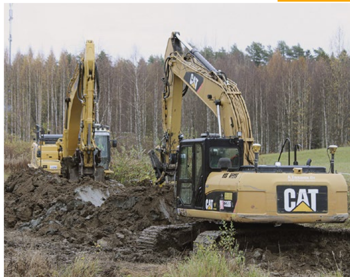
Pehmeillä paikoilla kaivanto täytetään välittömästi putkenlaskun jälkeen, jotta se ei sorru hallitsemattomasti.
