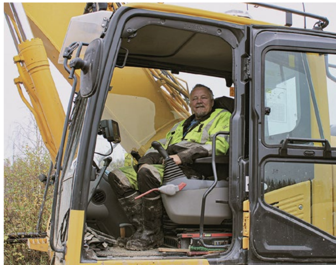
Toimitusjohtaja Aimo Tikkanen tällä kertaa itse siirtoviemärin kaivuutöissä.
