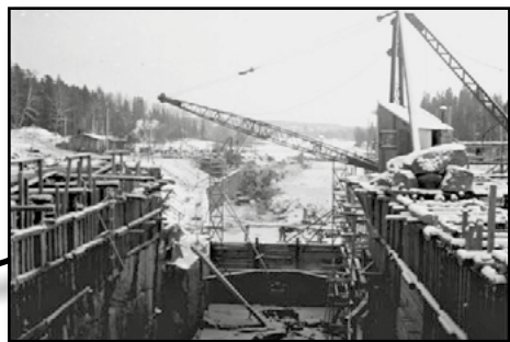
– Kanavan toisessa rakentamisessa oli mukana myös tehokasta konekalustoa. Mälkiän suursulun maanleikkaustöissä oli käytössä Orenstein & Koppel -kaivukone ja louhinnassa paineilmakalustoa. Kaivumassat siirrettiin kanavan pohjalla kapearaiteisen radan kuoppavaunuilla ja höyryveturilla. (Kuva Mobilia)
