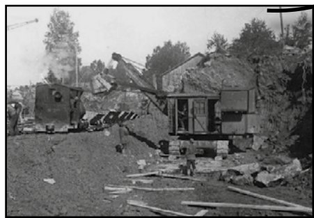
– Kanavan toisessa rakentamisessa oli mukana myös tehokasta konekalustoa. Mälkiän suursulun maanleikkaustöissä oli käytössä Orenstein & Koppel -kaivukone ja louhinnassa paineilmakalustoa. Kaivumassat siirrettiin kanavan pohjalla kapearaiteisen radan kuoppavaunuilla ja höyryveturilla. (Kuva Mobilia)
