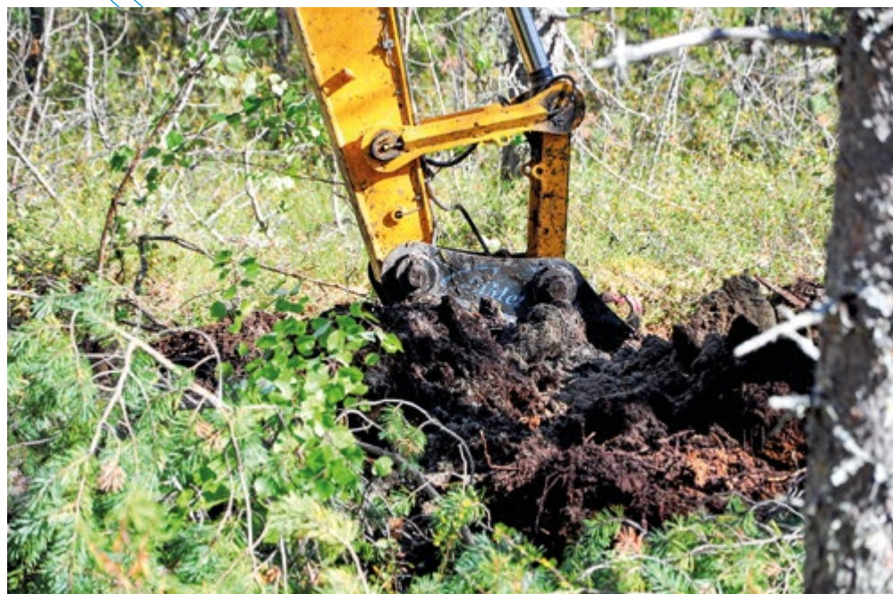
Syvän ojan kaivu. (Kuva: Jani Antila, Tapio Oy)
