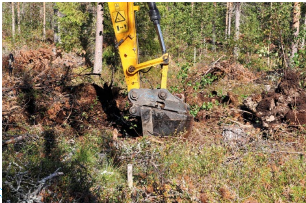
Matalan ojan kaivu. (Kuva: Jani Antila, Tapio Oy)
