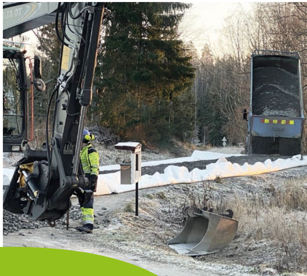
Härkäläntielle rakennettavien koerakenteiden tekoa. (Kuva: Anne Valkonen / Via Blanca Oy)
