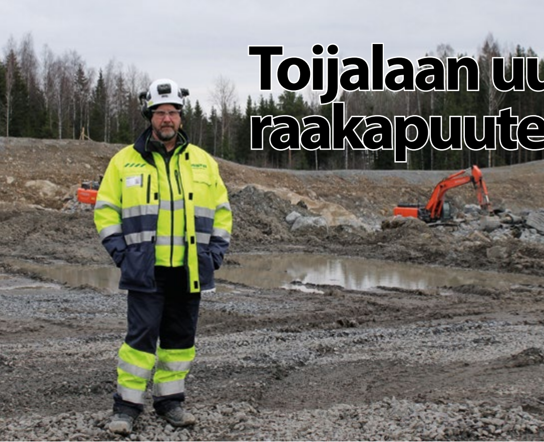
Destian työmaapäällikkö Hannu Sippala tasanteella, jolle talven roskaiset lumet varastoidaan.
