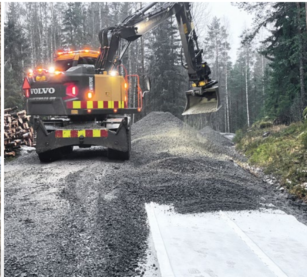
Salaojamatot on asennettu koerakenteeseen ja niiden päälle levitetään kiviaineskerroksia. (Kuva: Anne Valkonen / Via Blanca Oy)
