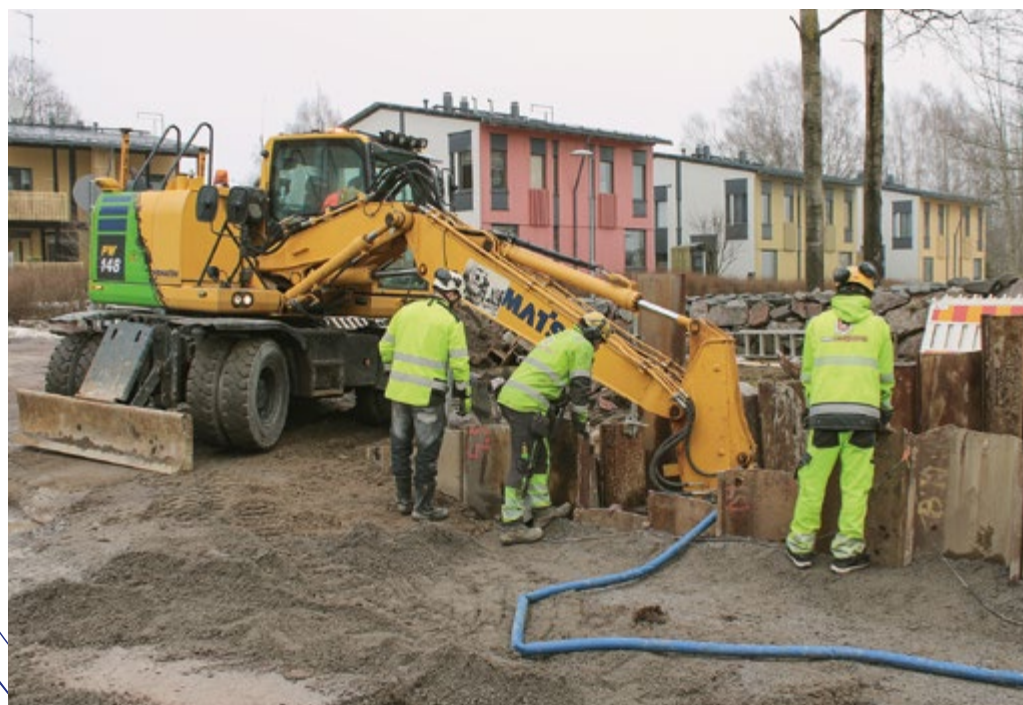
Lähes koko kaivukoneen ulottuvuus käytössä, jotta kaivannon pohja saadaan kaivettua oikeaan korkoon.
