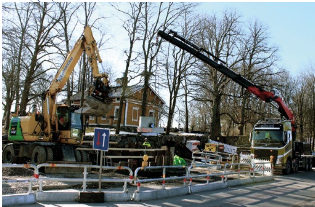
Mittavesikaivon rakentamisessa on useita työvaiheita, kuten kaivon osien asentaminen paikoilleen.
