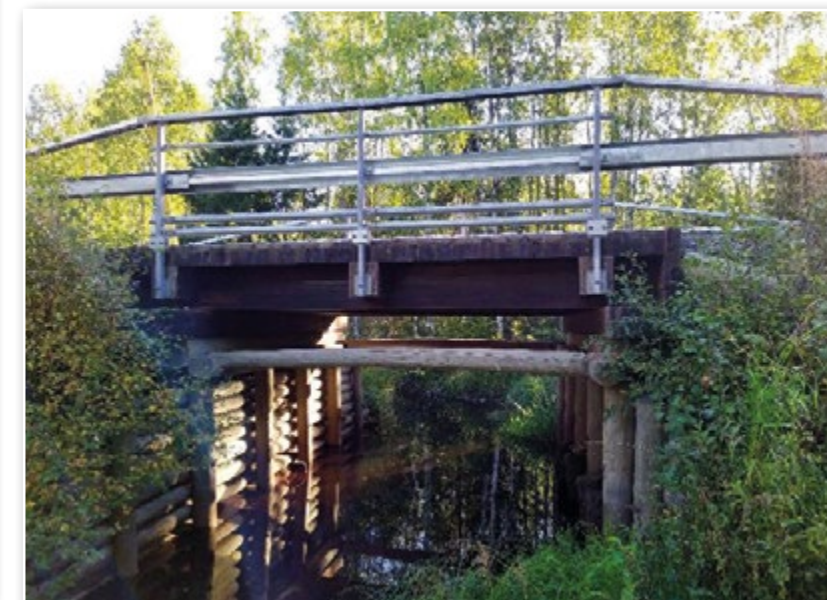
Vanha Kainuussa oleva puusilta on kunnostettu uusimalla kannatinpalkit, kansi- ja kaiderakenteet vastaamaan nykyvaatimuksia. Sillan turvallinen käyttö on varmistettu vuosikymmeniksi eteenpäin.
