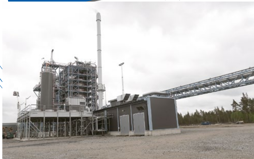
Aktiivihiihtehtas rakennettiin Ilomantsin lämpölaitoksen ja välillä jo suljettunakin olleen Vapon pellettitehtaan kanssa samalle tontille. Toukokuussa 2021 saatiin piipusta toiminnan aloittamisesta kertovat ensimmäiset "savut", käytännössä vesihöyryä.
