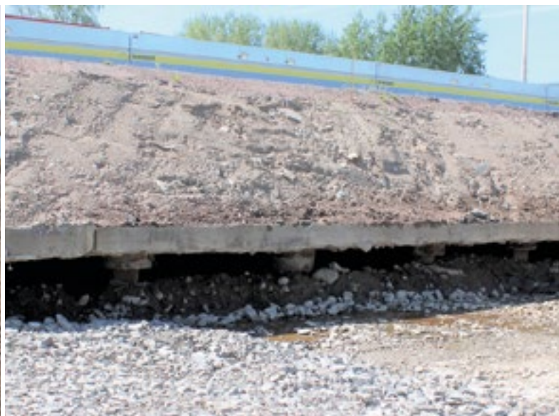
Maa on vajotessaan synnyttänyt useiden kymmenien senttien tyhjätilan 90-luvulla tehdyn paalulaatan alla.
