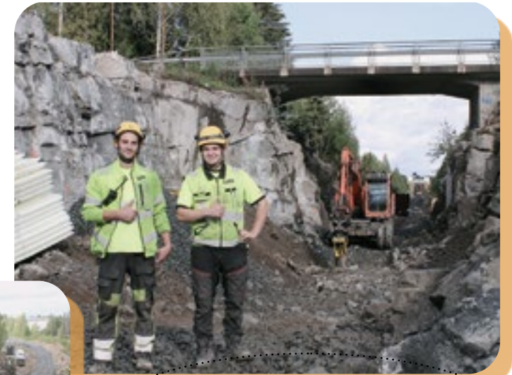
Tyytyväisiä radanrakentajia. Toni Ålander ja Joni Komulainen peukuttavat alan valinnalleen lisälmes- sä kallioleikkauksen syvennys- ja levennystöissä. Joni on radanrakentaja jo toisessa polvessa ja valmistuu ensi jouluna rakennusmestariksi (AMK).
