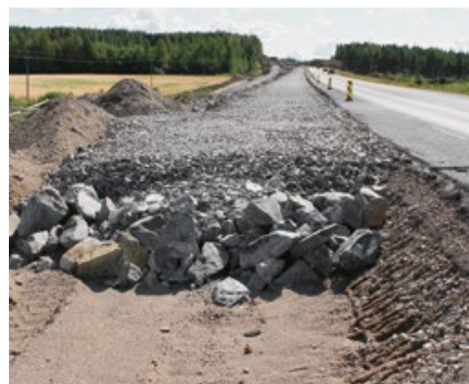
Toinen puoli tiestä levitettyä, jakavan kerrosmateriaalina on louhe. Murske on murskattu työmaalla.
