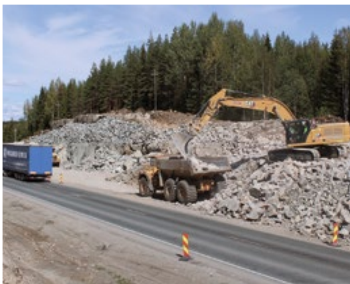
Työskentelyssä on oltava varovainen, kun valtatie liikenne pysäytetään vain räjäytyksen ja sitä seuraavan tien puhdistuksen ajaksi.
