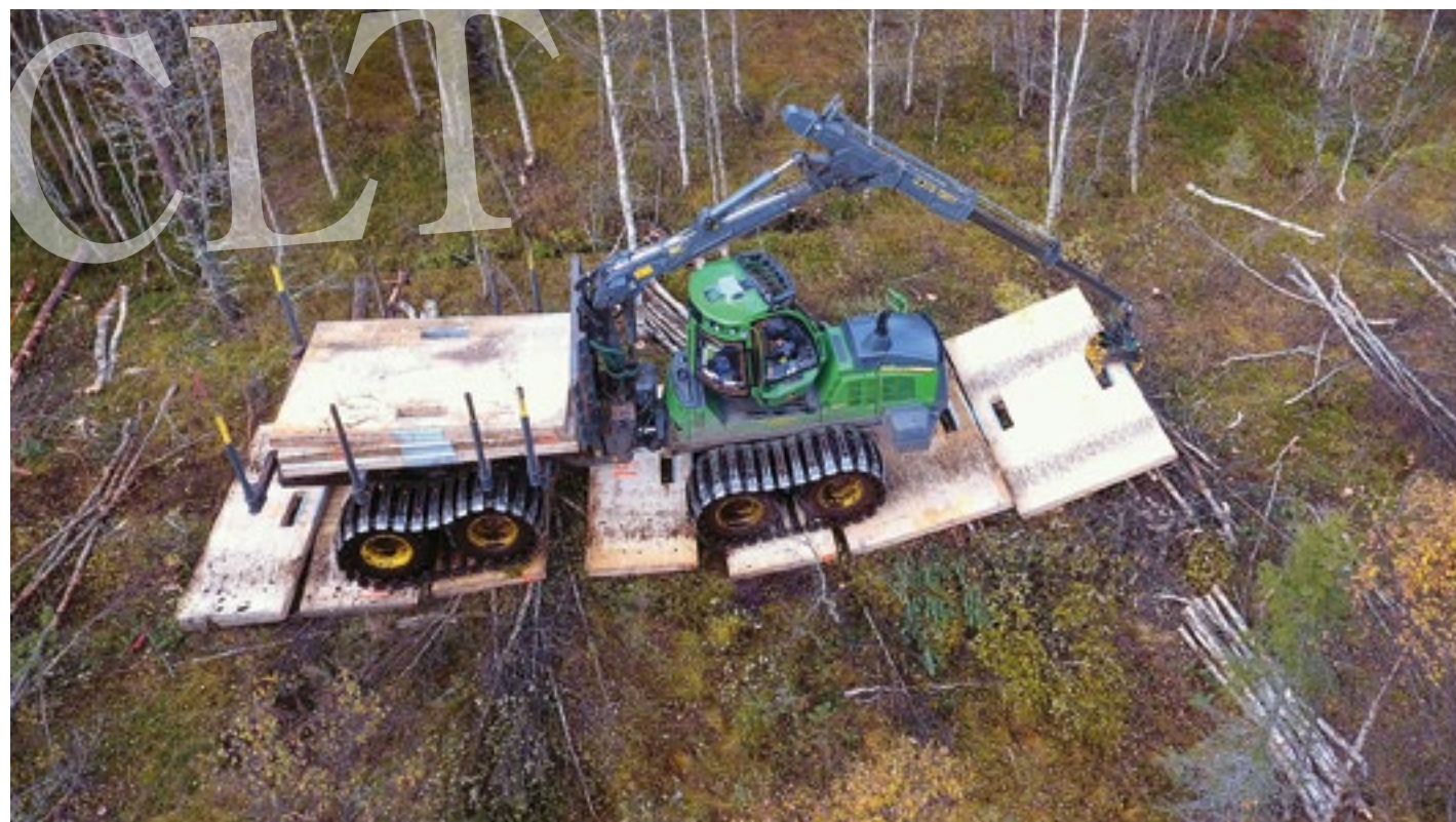
CLT-levyjen asentamista turvemaakohteella Narkauksessa.
