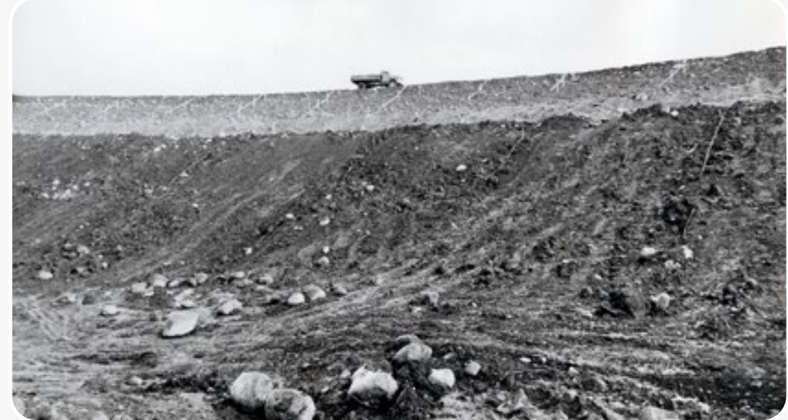
Korkeimmillaan 24 metrisen reunapadon sydämenä käytettiin vaihtoehtoisesti savea tai moreenia. Tukirakenteen muodostivat tiivistyssydämen molemmiin puoliin sorasta rakennetut tuki- ja painopenkereet. Kuva: Infra ry/Mobilia
