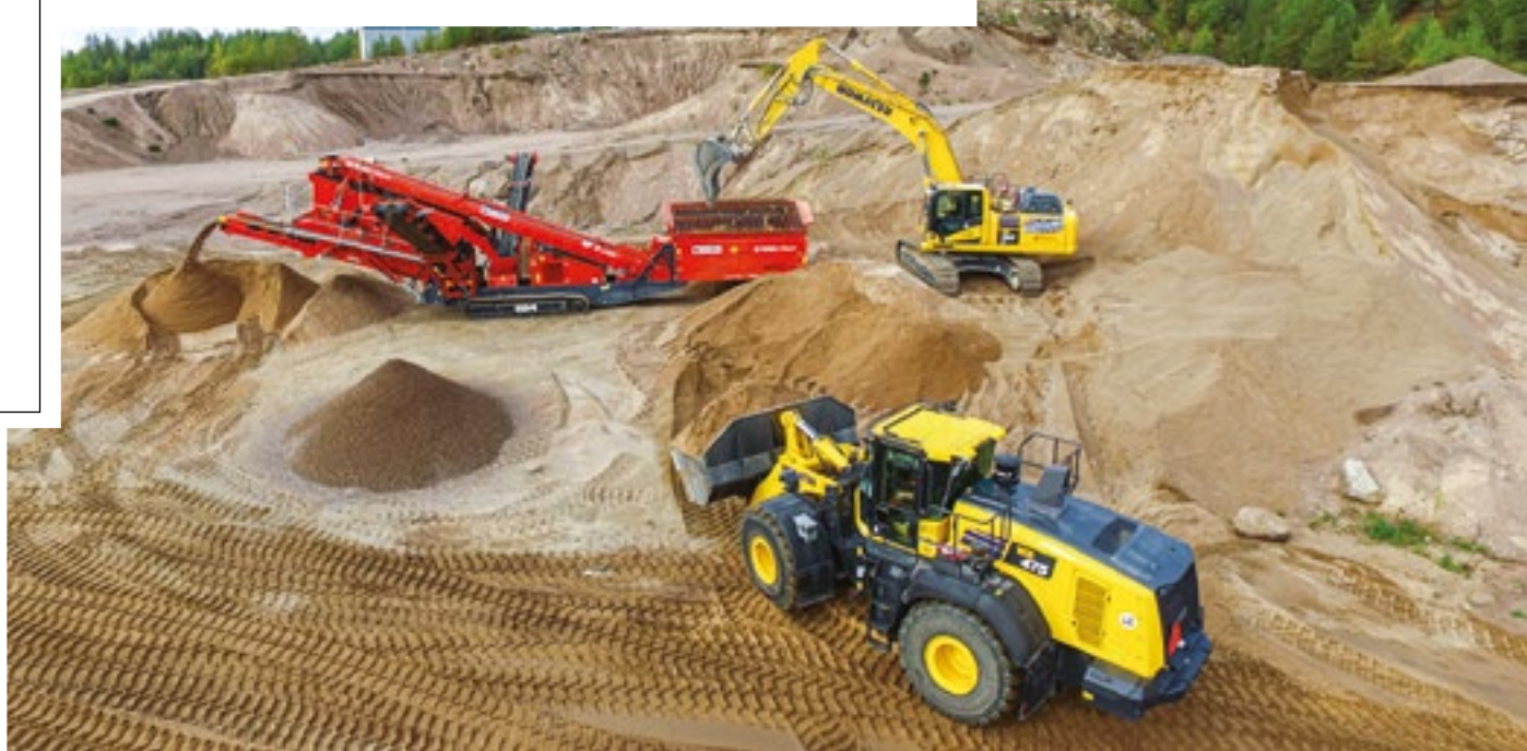
Vuodesta 2021 ainakin vuoteen 2025 asti paras tapa vähentää työkalu- ja koneiden päästöjä on käyttää työmailla hybridikoneita sekä optimoida työmaiden työnkulkuja. (Suomen Rakennuskone Oy / Joni Niskala)
