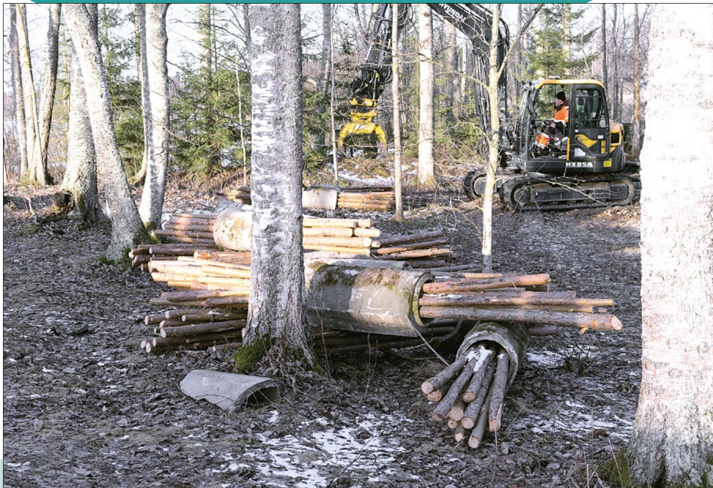
Talkootyönä valmistetut uppopuupuhdistamon rankaniput ovat valmiita asennettavaksi.
