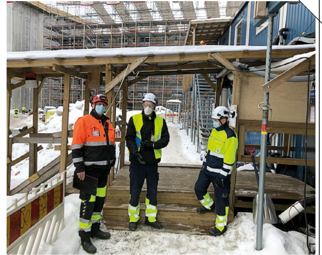
Mittajat uuden kerrostalokohteen työmaalla.
