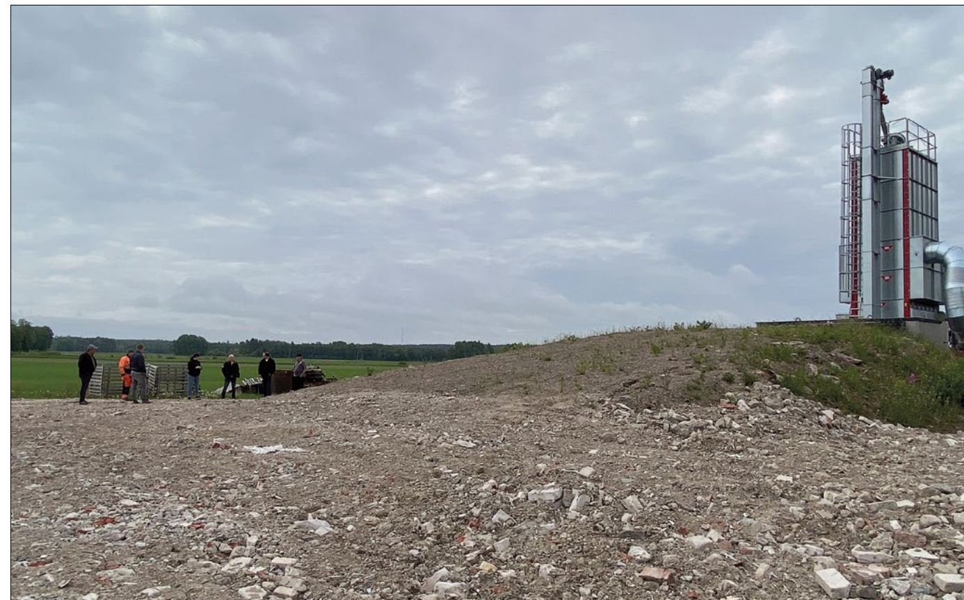
Kuivurin ajosiltaa ja huoltotiehen kierrätettiin purkubetonia.
