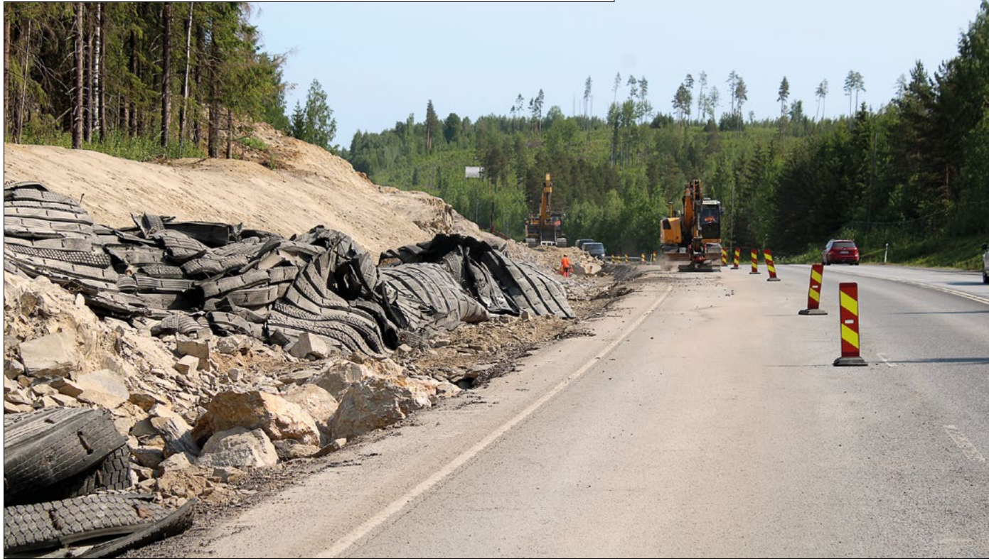
Tietä levitettäessä tulee myös louhittavaa kalliota vastaan. Louhe käytetään rakennettaviin yksityisteihin.
