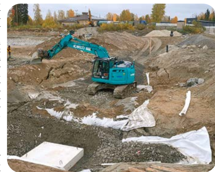
Jätevedenpumppaamon pohjatöitä Lieksassa urakkana kesällä 2022. Kuva Jussi Leppänen
