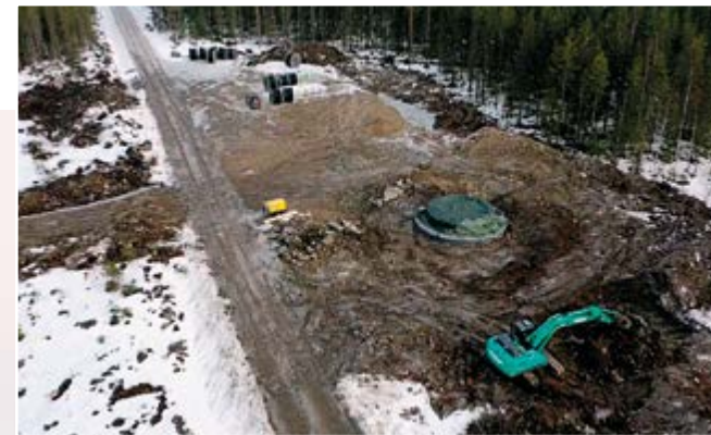
Maarakennus Hautala Oy on viime vuosina urakoinut paljon tuulivoimalatyömailla, tässä urakoidaan Kristiinankaupungissa. Kuva: Maarakennus Hautala Oy.
