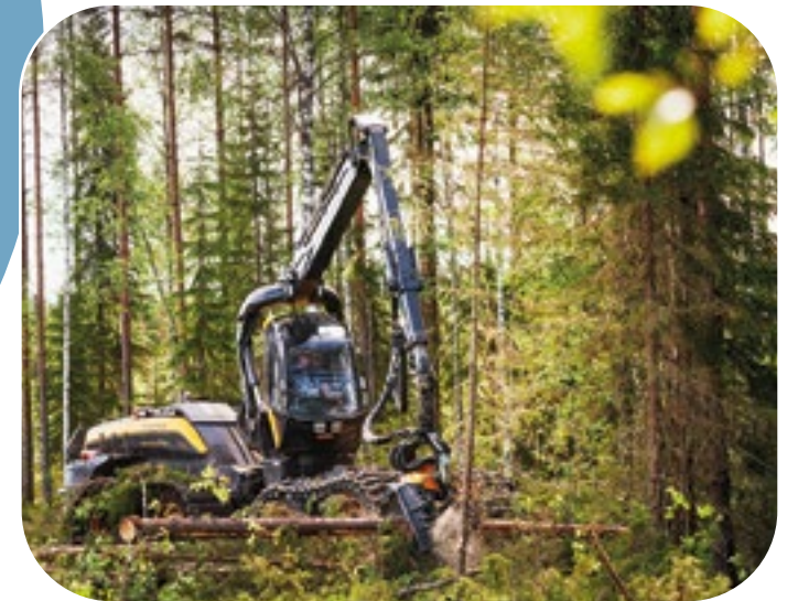
Työnäytöksessä on esillä Ponssen konekalusto Metsä Groupin työmaalla. Valokuva: Ponsse Oyj.
