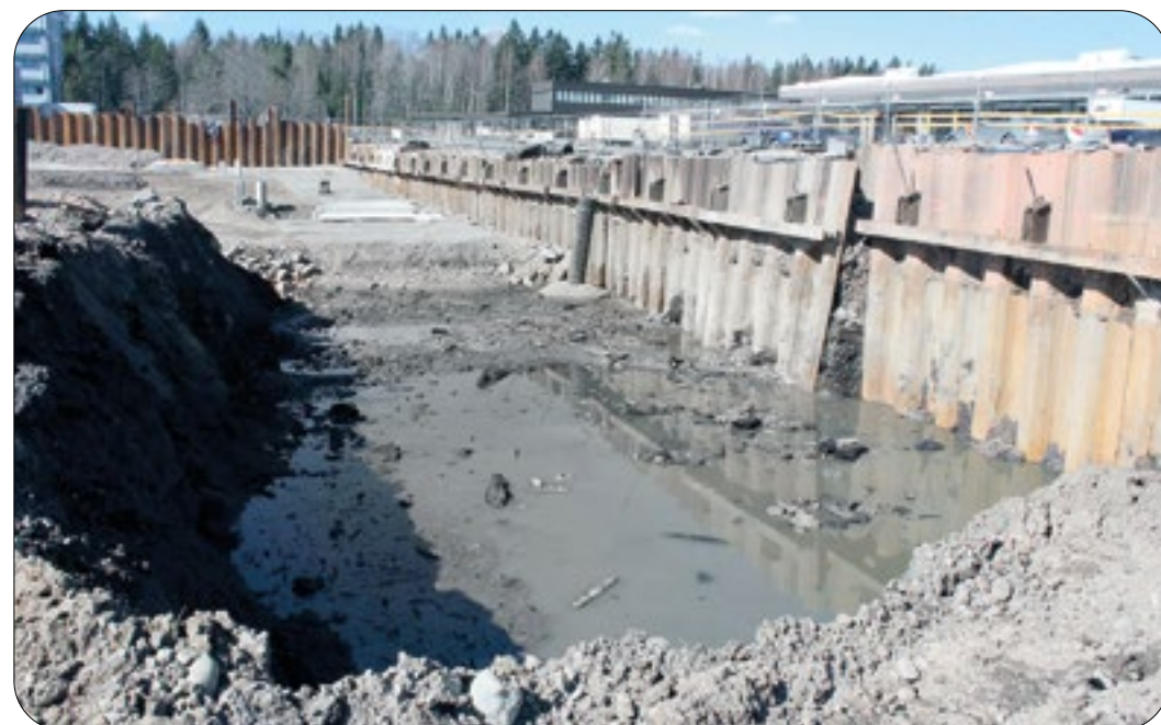
Kaatopaikkajätteen poiston jälkeen alkaa uusien rakenteiden rakentaminen.
