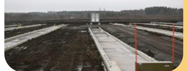
Kennotelineiden perustukset. Yksi betonipalkki on 12-metrinen, yhteensä niitä on noin 13 600 kappaletta koko alueella. Kuva: Tapio Hirvikoski
