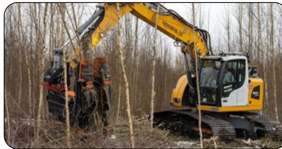
Vemarak Oy:n Marko Tulokas tekee metsätöiden lisäksi kaivinkoneella myös vesi- ja maanrakennushommia (Kuva: Jussi Laurila).
