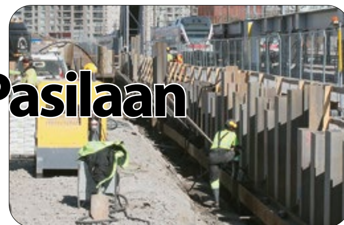
Ratapihan puoleinen ponttiseinä ankkuroidaan peruskallioon.
