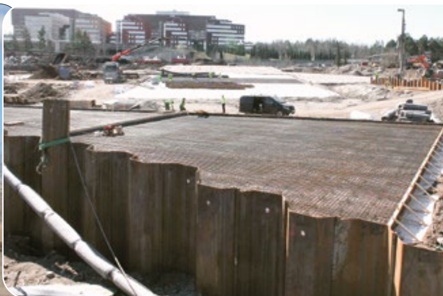
Kaikki tulevat katurakenteet perustetaan paalulaatoille.
