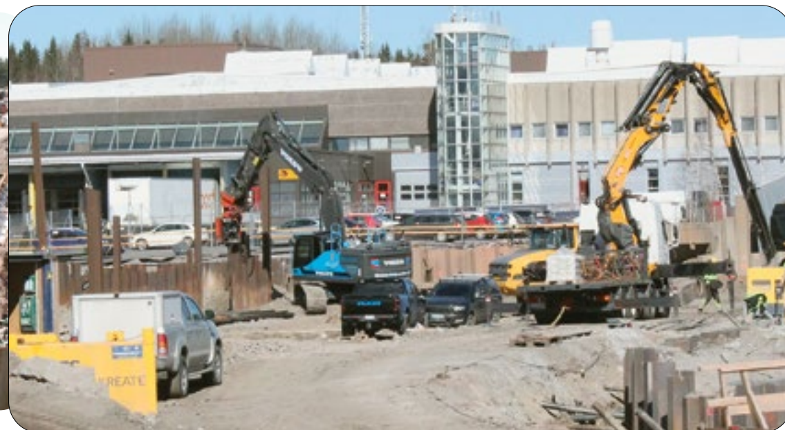
Työmaa on vilkas, koska useita työvälineitä tehdään samanaikaisesti.
