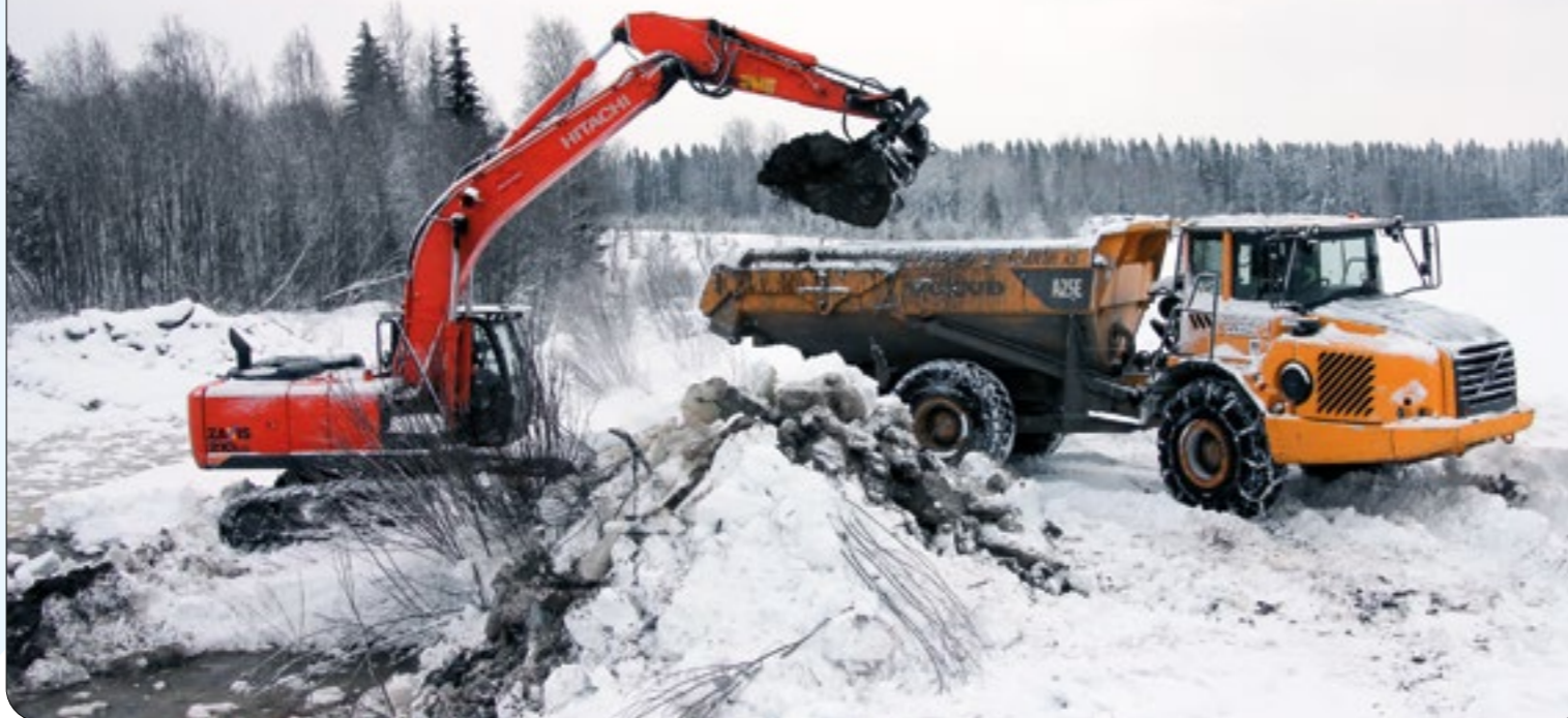
Ennen lasketusaltaan tyhjennystä sen vedenpintaa on laskettu noin puoli metriä tyhjennyksen helpottamiseksi.
