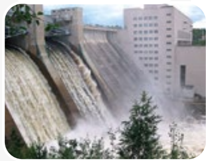
Pyhäkosken voimalan pudotuskorkeus on 32 metriä ja tulvajuoksuotukset ovat komeita.
