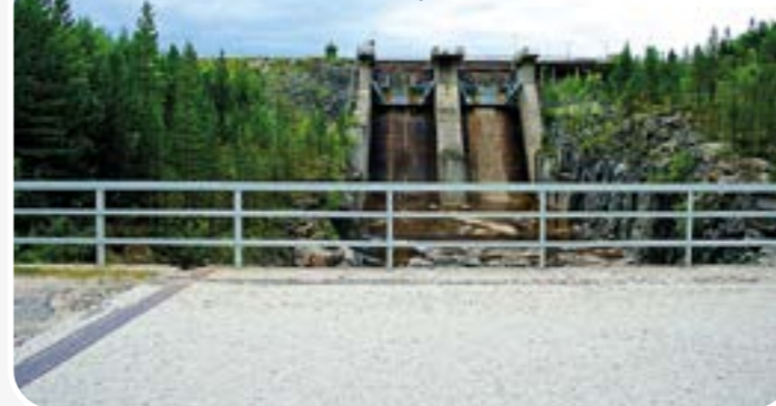
Kallioon louhittu tulvakanaava on suljettu teräksisillä sektoriluukuilla.
