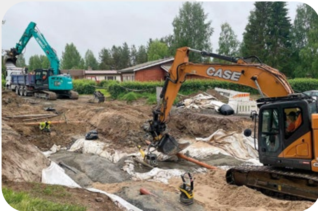
Lieksan työmaalla työskentelee kaksi JL Konepalvelu Oy:n kaivukonetta sekä maarakentajaa. Kuva Jussi Leppänen
