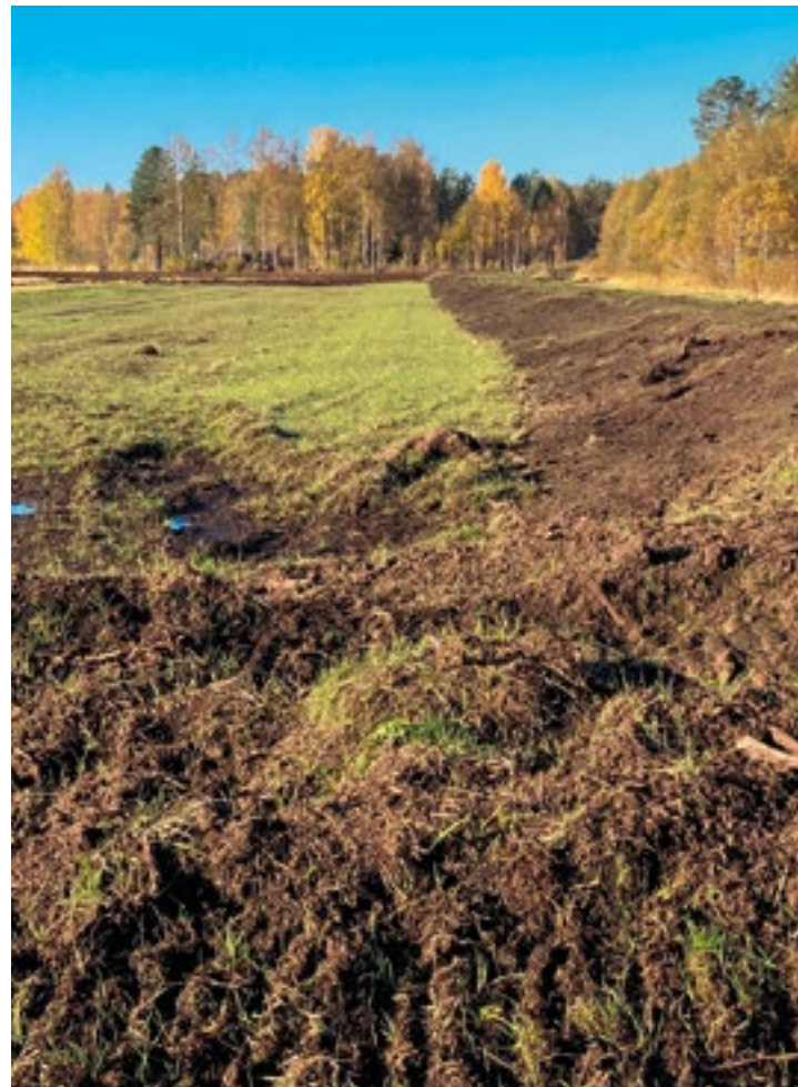
Maatalouteen huonosti kelpaavan pellon voi tehdä kosteikoksi. Pellon reunojen pengerrys kaivinkoneella on kaiken lähtökohdana.
