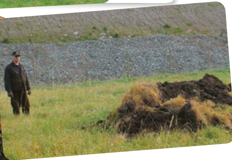
Maanomistaja Veijo Muli taustallaan meluvalli, josta valuneet maat olivat täyttäneet ojat. Edessä koekuoppa, josta salaojan tukkeutuminen on todettu.
